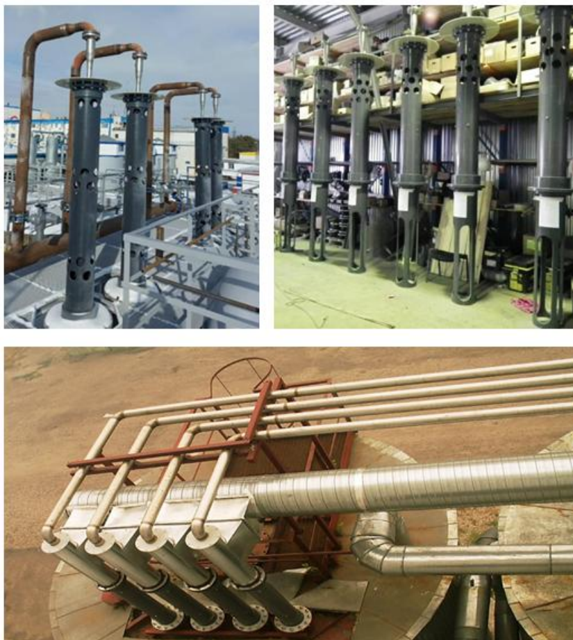
Рисунок 34 – Эжекционные декарбонизаторы
