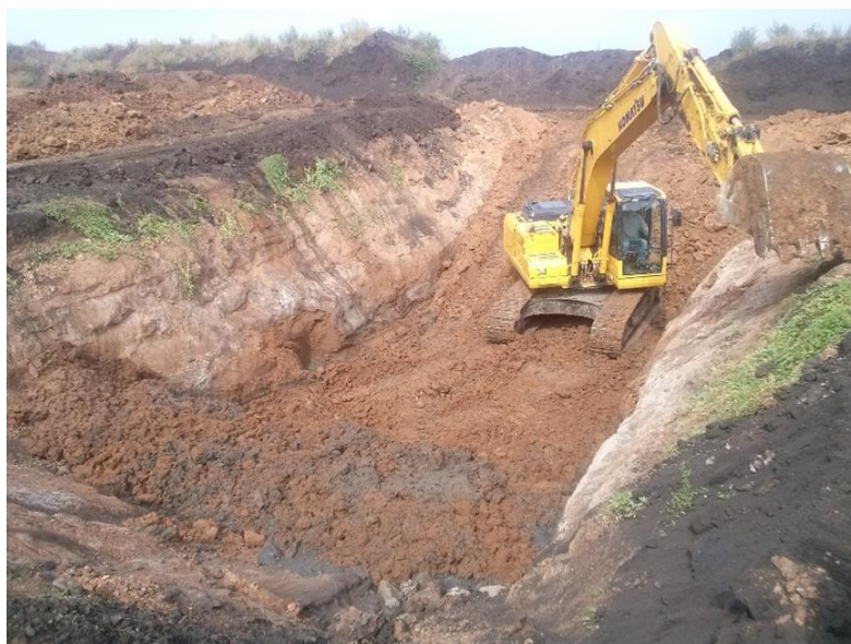
в) перемешивание готовой смеси на площадке
